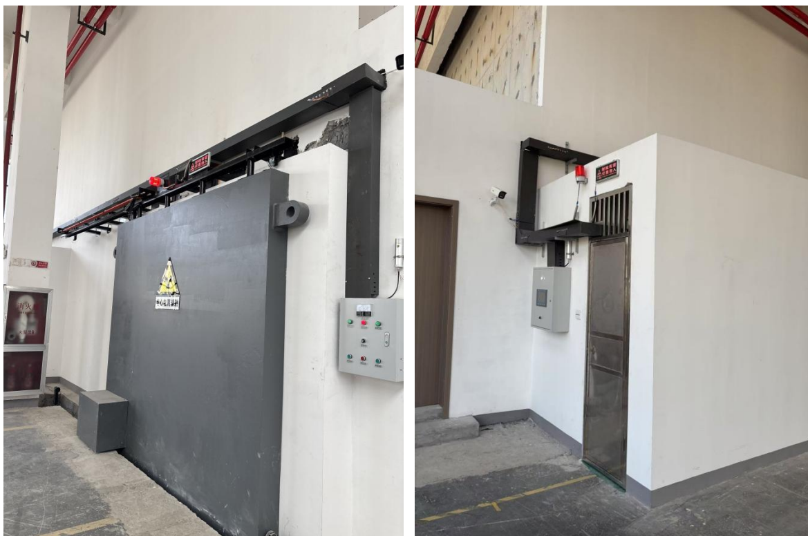
图4-2 1#加速器生产调试机房电离辐射警示标志及工作状态指示灯
